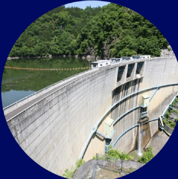
裾花ダム (長野県建設部)
