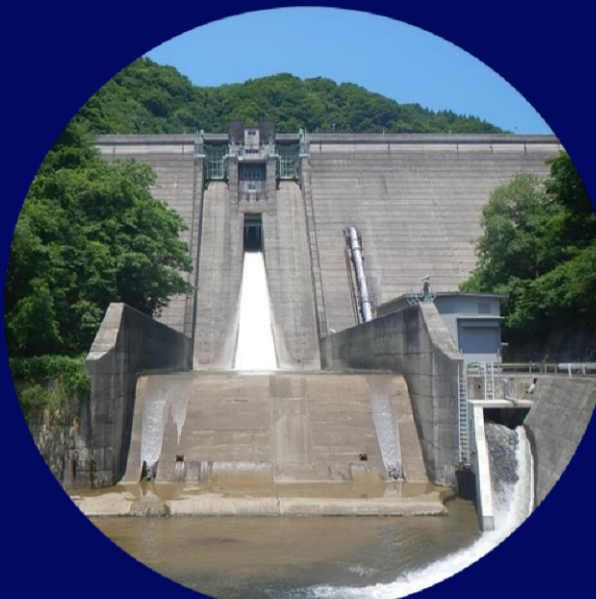
奥裾花ダム (長野県建設部)
