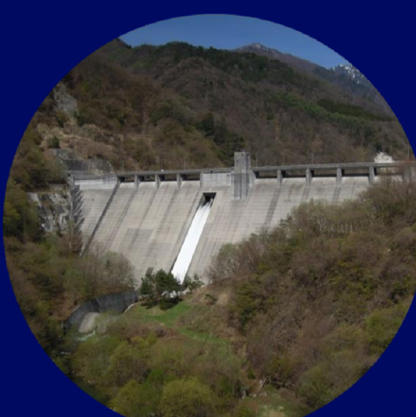
片桐ダム (長野県建設部)
